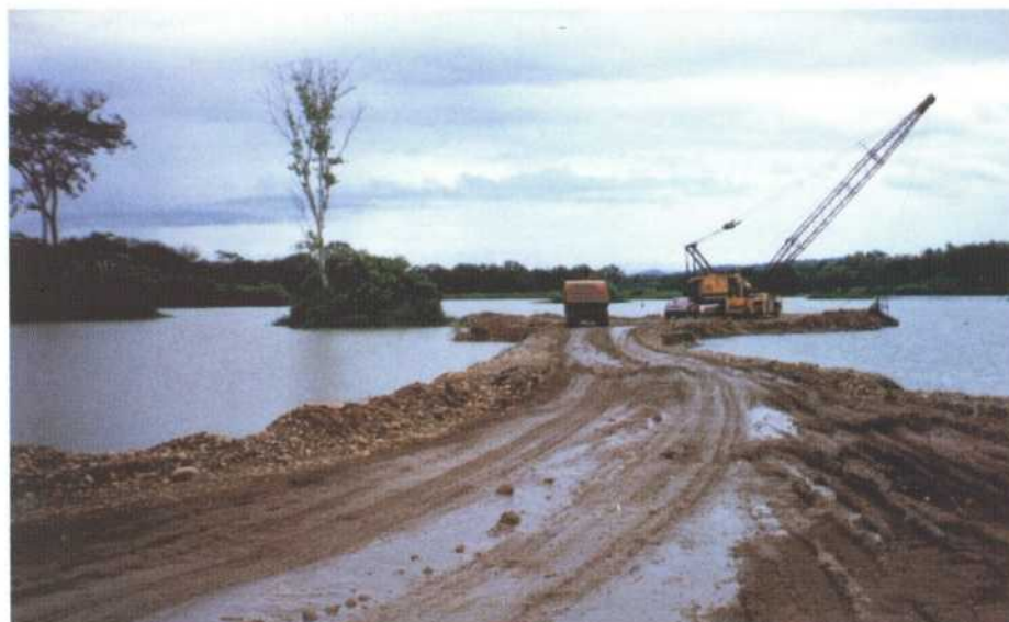
Extracción de grava y arena en el río Chagres.
